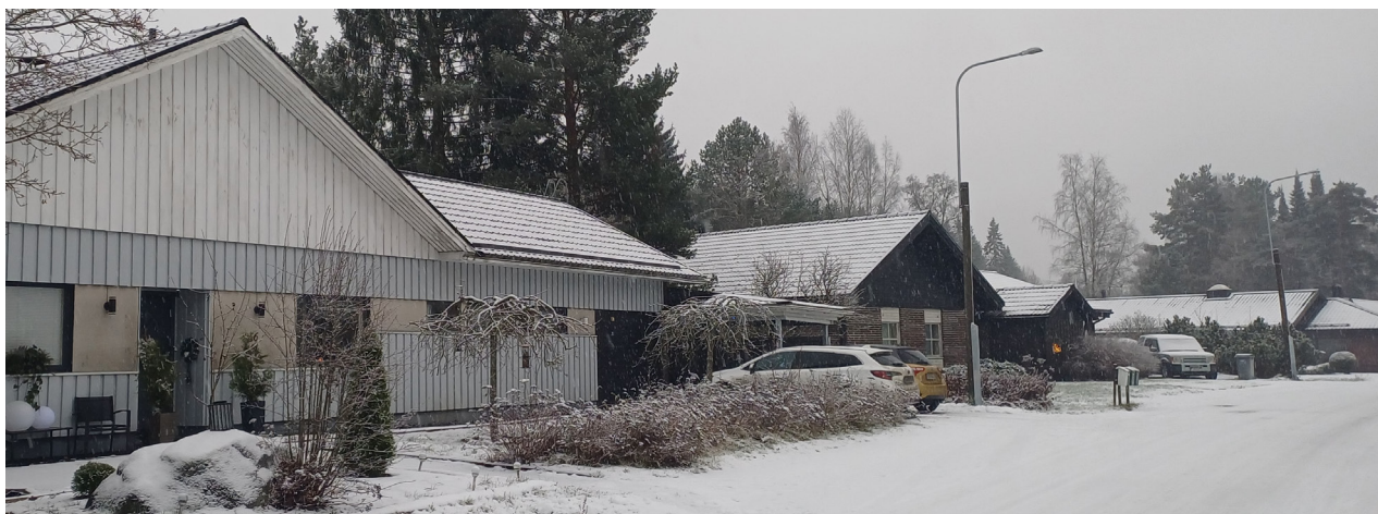
Kuvat 7. Näkymä Simakankadulta. Länsiosan rakennuskanta muodostui 1960-70 -luvulla ja on kokenut merkittävän muutoksen kattomuotojen muuttuessa.
