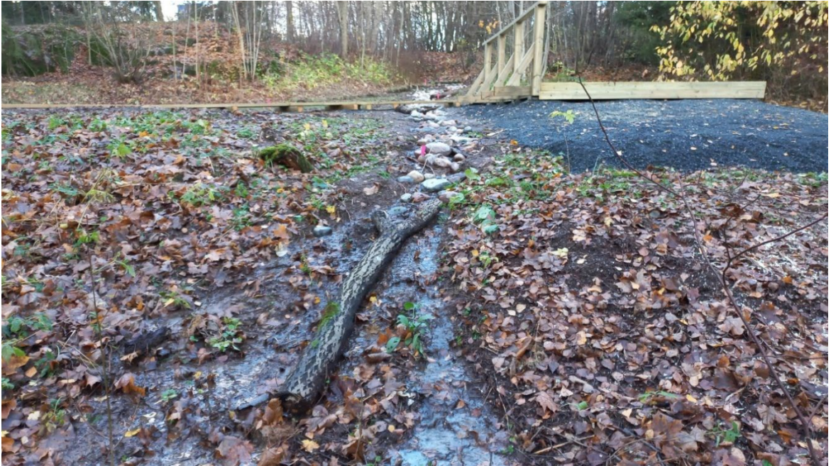
Kuva 31. Esimerkki hulevesien ohjaamisesta painanteessa Forssan Nummilähteellä. (Forssan kaupunki, 2024)
