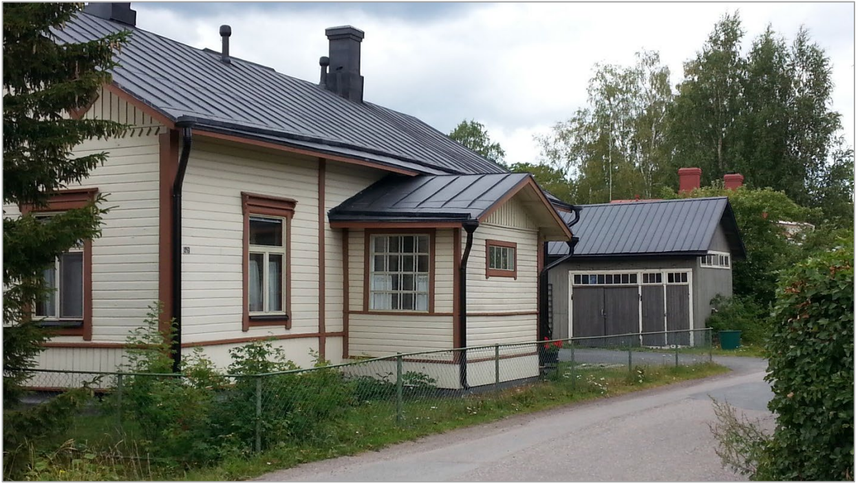
Käsityöläiskadun varrella sijaitseva kaava-alueen kiinteistö 61-7-32-9 nähtynä Palotorilta.
