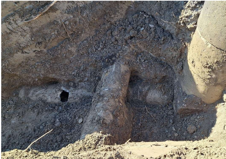
Kuva 2. Rikkoontunut viemäriputki
