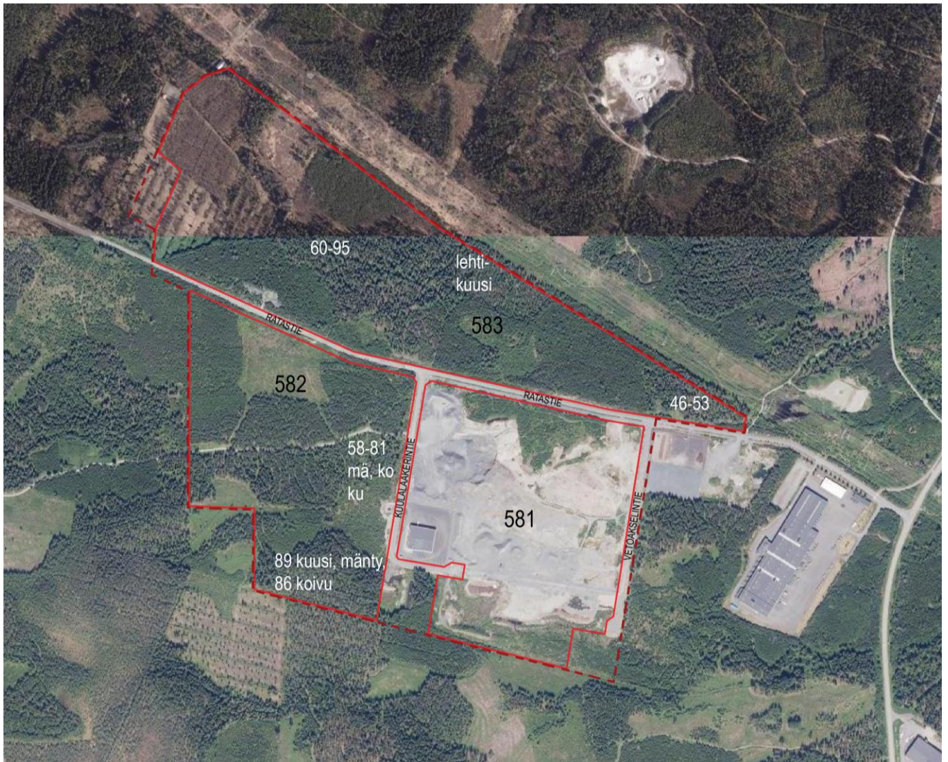
Kuva 3. Pohjoinen kortteli 583 ja läntinen kortteli 582 ovat rakentamattomia. Ratastie on asfaltoitu noin kaava-alueen puoleen väliin, loppu on soratienä. Kuulalaakerintie on asfaltoitu. Muokkaamattomat tai rakentamattomat korttelialueet ovat pääosin talousmetsää. Itäinen kortteli 581 on pitkälti muokattu rakennettavaksi tai lounaiskulmastaan rakennettu. Ratastie on asfaltoitu Kuulalaakerintielle saakka. Korttelin 582 ja 581 välissä oleva Kuulalaakerintie on asfaltoitu. Korttelin 581 itärajalla oleva sorapintainen Sylinterintie ei ole vielä käytössä. Sähkölinja näkyy suunnittelualueen pohjoispuolella. Ilmakuva vuodelta 2023–24 (Lähde maanmittauslaitos). Puustotiedot kaupungin metsänhoitosuunnitelma.
