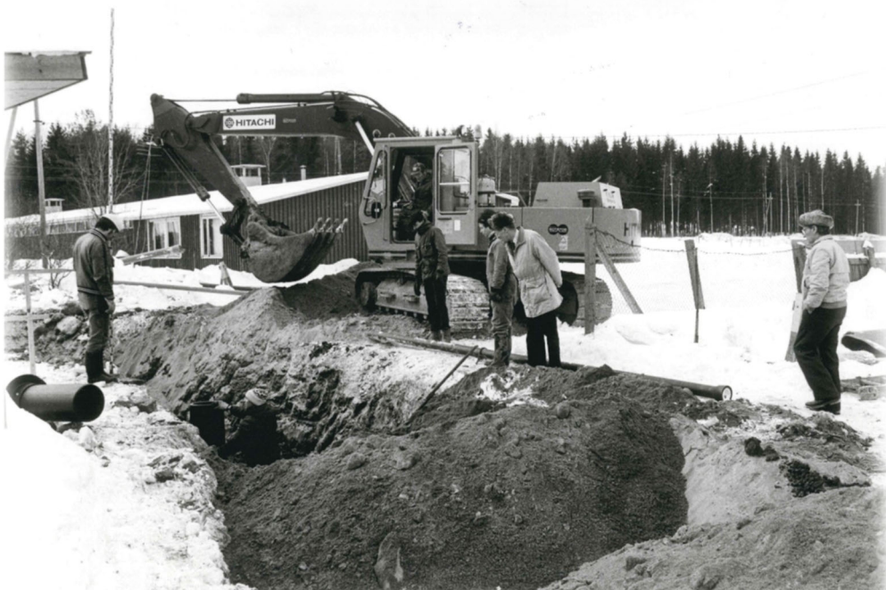
Kuva 6, Vesilaitoksen johto tarkastamassa työmaata 1986
