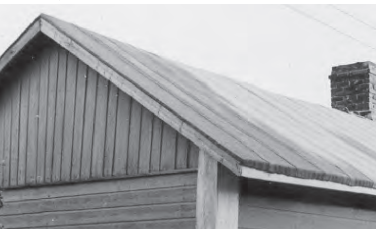
Pärekatto, näkyy palokujalla sekä asuinrakennuksessa että ulkorakennuksissa. Kolmiorimahuopakatoissa kapeat huovat tulevat räystäälle saakka.
