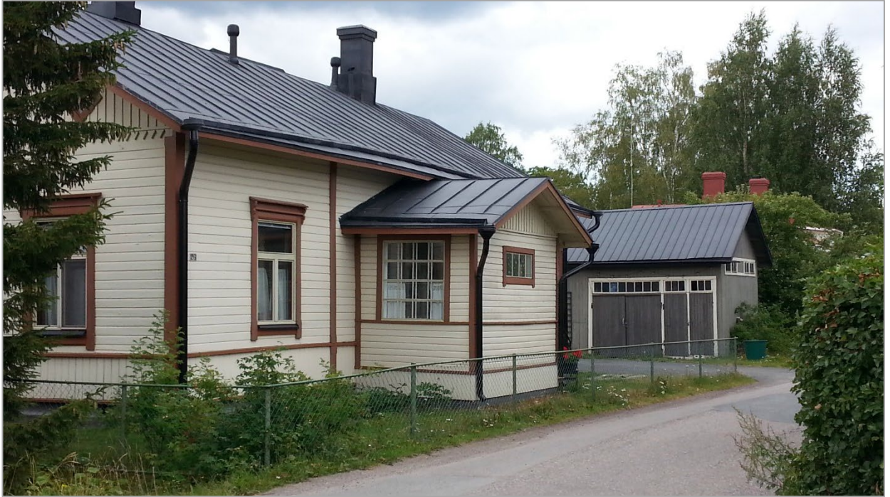
Käsityöläiskadun varrella sijaitseva kaava-alueen kiinteistö 61-7-32-9 nähtynä Palotorilta.
