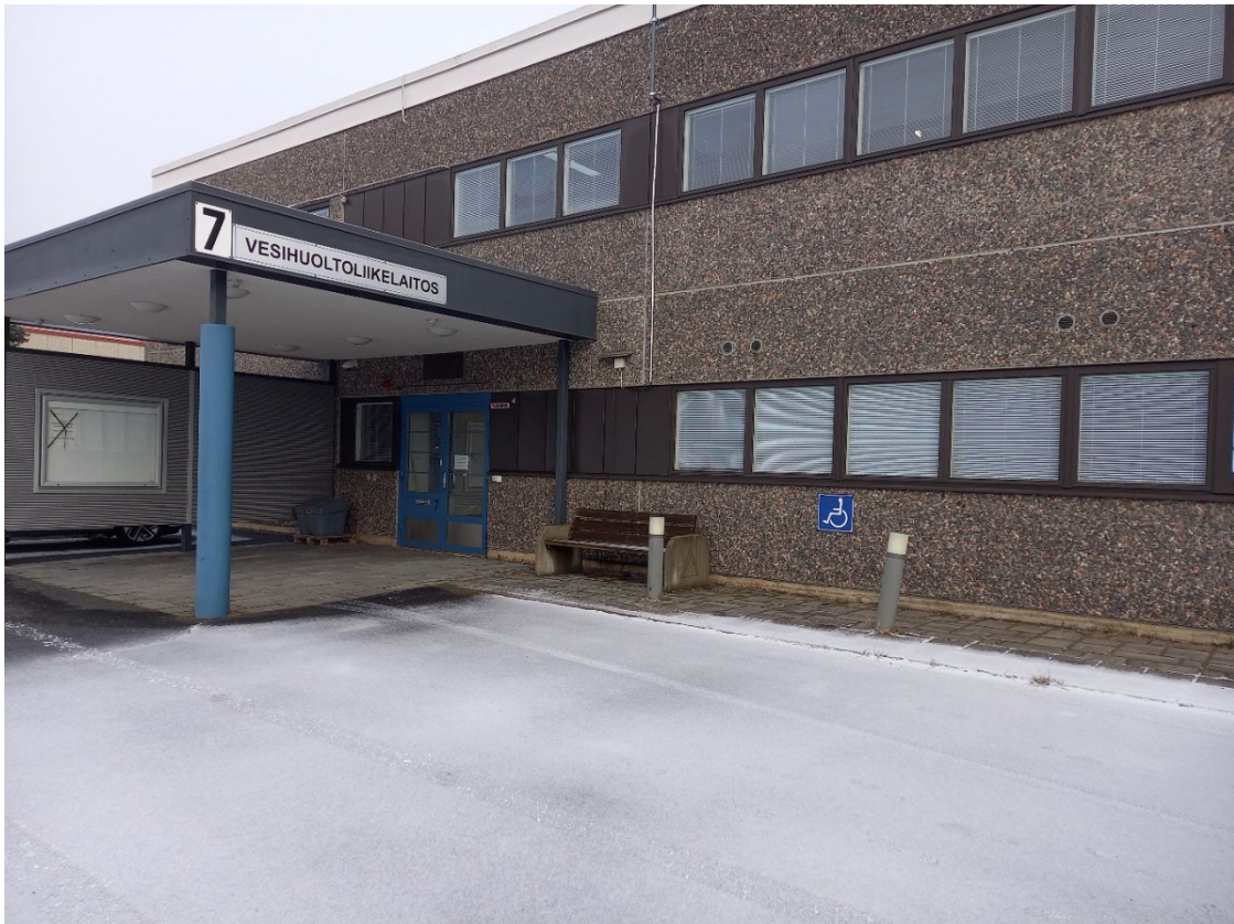
Kuva 8, näkymä vesihuoltoliikelaitoksen toimitilojen sisäänkäynnistä
