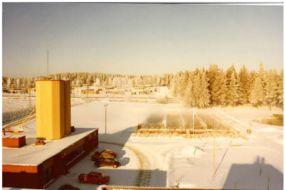
Kuva 5, Forssan jätevedenpuhdistamo vuonna 1977
