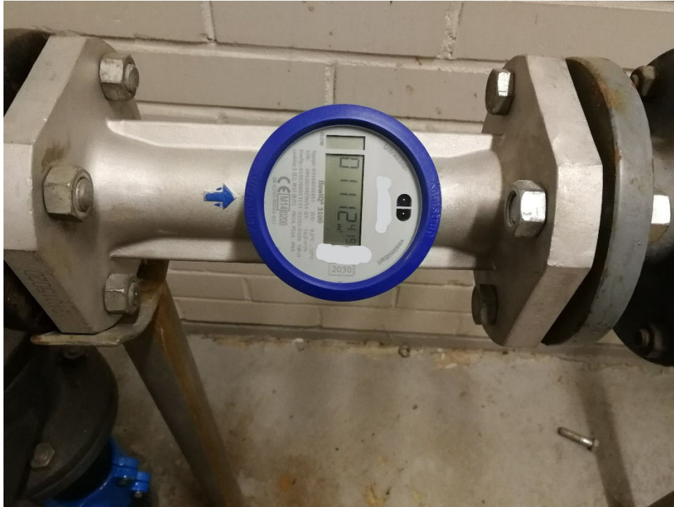
Kuva 6, etäluettava vesimittari
