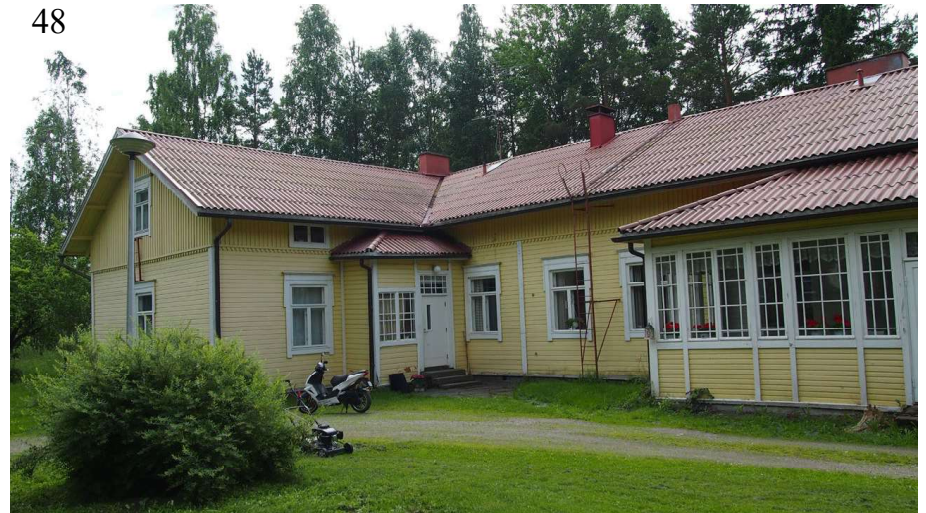
Kuva 48: Asuinosa on yksi ikkunatyyppi, joka on sopusointuisessa suhteessa julkisivuun. Suuri valoisa lasiveranta, jonka rinnalla on pieni myös detaljoiduin ikkunoin varustettu pienempi kuisti. Valokuva Kojjärven inventointi Forssan kaupunki E 4:9.
