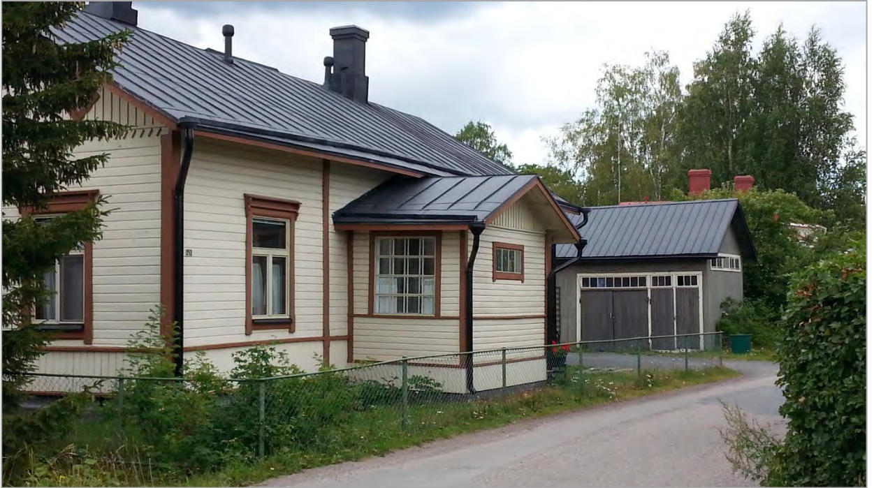
Käsityöläiskadun varrella sijaitseva kaava-alueen kiinteistö 61-7-32-9 nähtynä Palotortilta.
